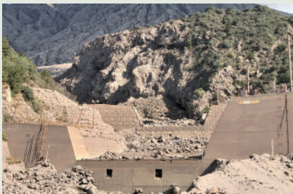
手前、野尻川7号堰堤。奥、野尻川8号堰堤。
